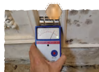
房屋周边及室内环境检测
